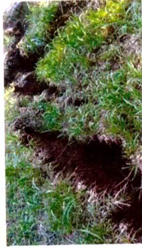
Figura 04. Detalhe para as fissuras no terreno.
